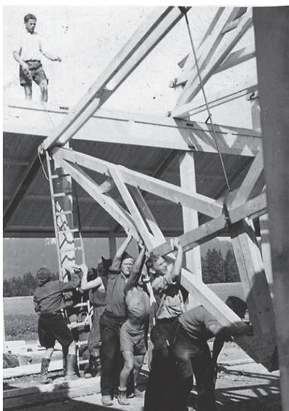
Abb. 49: Aufrichten der Dachbinder in Oberpleis
