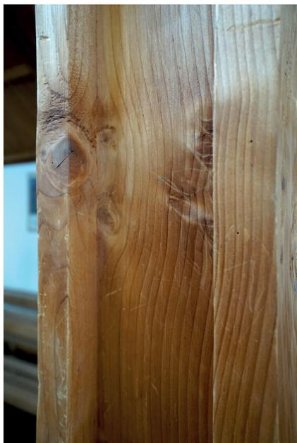
Abb. 103: Detail einer Stütze in der Friedenskirche in Neufahrn, woraus klar wird, dass die Stütze aus einem Holzquerschnitt gebrannt wurde
