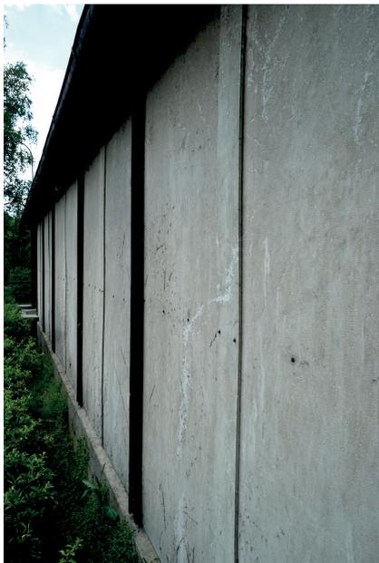
Abb. 98: Zementfaserplattenverkleidung an der Friedenskirche in Neufährn
