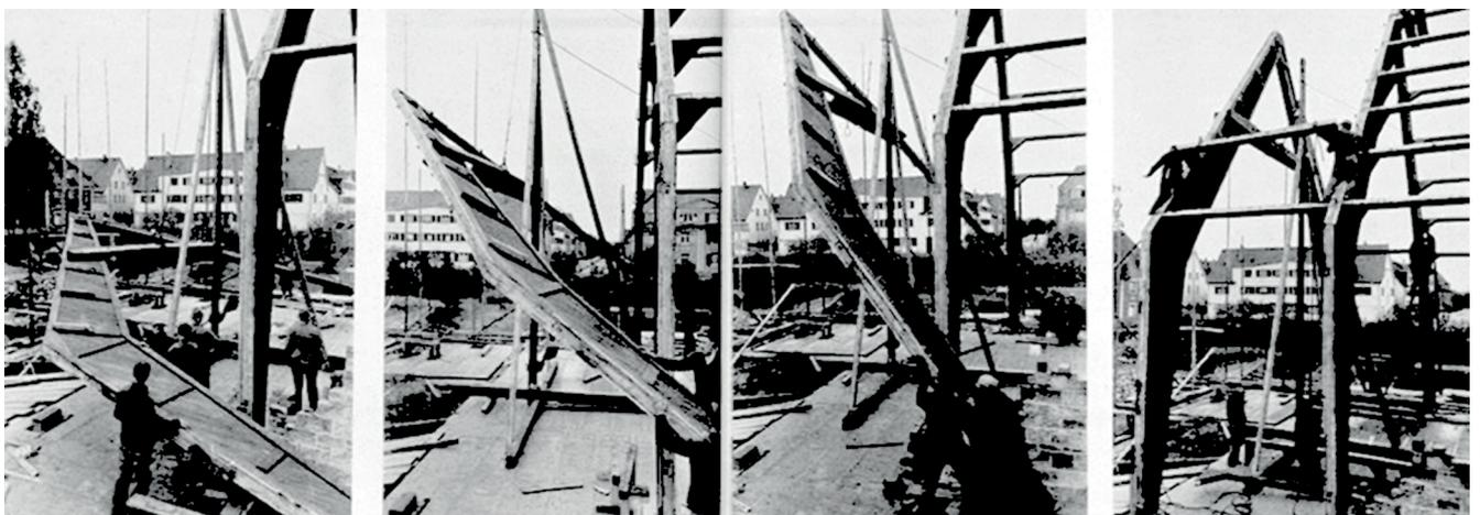
Abb. 40: Errichten einer Notkirche des Typs B
