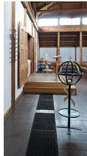
Abb. 74: Auslässe der Umluftheizung
