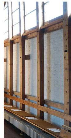
Abb. 82: Eingestellte Holzkonstruktion, Sitzbankradiatoren
