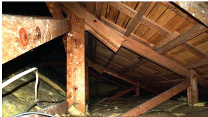
Abb. 97: Blick in den Dachraum in der Kreuzkirche in Pocking. Die Decke ist mit Mineralfüllung abgedeckt
