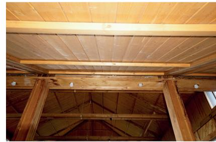
Abb. 95: Originale Leuchtauslässe und feuchtebedingte Schädigungen bei der Christuskirche in Viechtach
