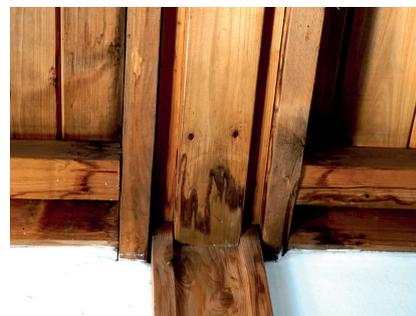
Abb. 65: Anschluss der Stützen an die Sparren in Höhe der Traufen, Viechtach
