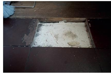
*Abb. 100: Originaler Plattenbelag in der Kreuzkirche in Pocking. Eine gelockerte Platte konnte entnommen werden. Sie besteht wohl aus Holzzement*
